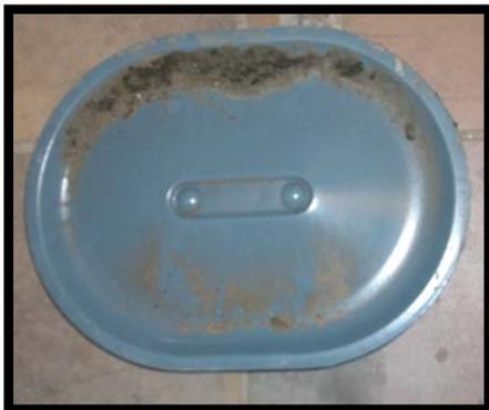
*Foto: Erhebliche Feinstaubablagerungen innerhalb eines Revisionsdeckels im Zuluftkanal*
