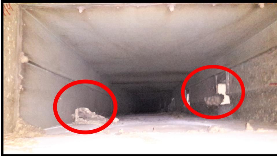
*Foto: Innenseitiger Zustand des Zuluftkanals im Bereich der Fensteranlage Schwimmhalle*
