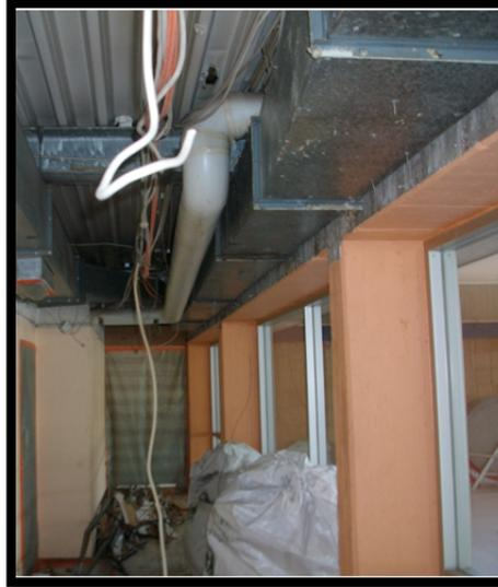
Foto: Freiliegender Luftkanal nach Ausbau der Holzdecke
