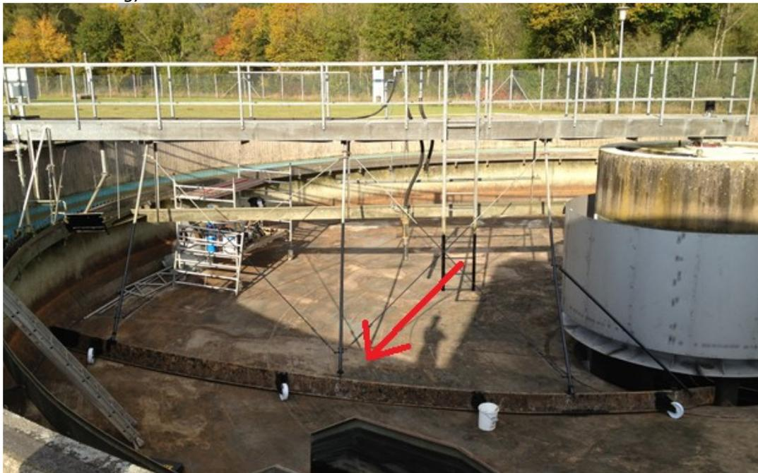
Dazu dreht sich das Bodenräumwerk mit der gesamten Brücke wie ein Uhrzeiger um das Mittelbauwerk herum. Für einen Umlauf benötigt das Räumwerk rd. 40 min. In den 40 Jahren Betriebszeit hat das Bodenräumwerk inzwischen rd. 21.000 km zurückgelegt.
