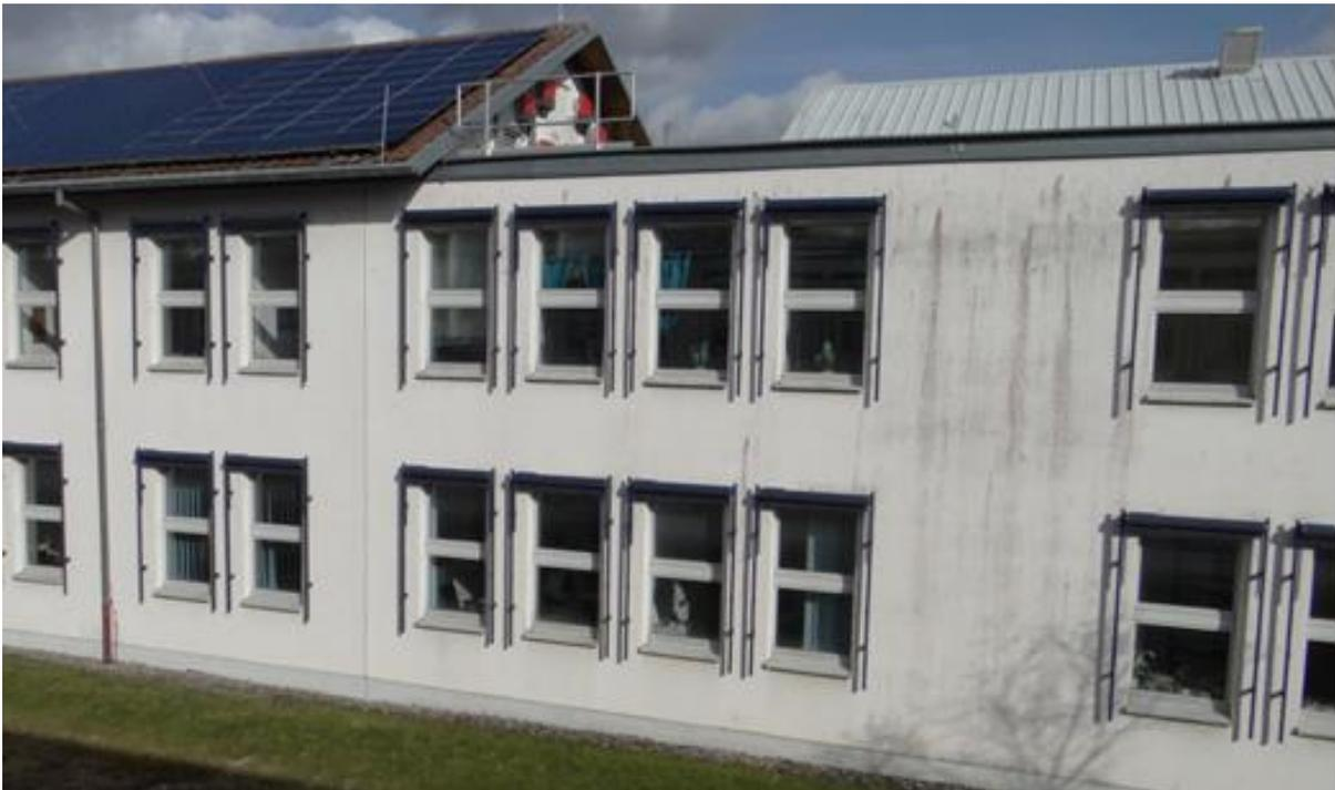
Abbildung 2-17: Dachüberstand Gebäude. Der Dachüberstand auf der linken Seite verhindert die Veralgung, welche auf der rechten Seite deutlich zu sehen ist<sup>41</sup>
