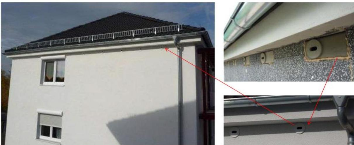
Abbildung 2-2: Abgeschlossene Nistkasteneinheit (Einbaustein) in der äußeren Wärmedämmung und im Traufkasten (je Einflugloch ein Brutkasten mit 20x30 cm)<sup>9</sup>
