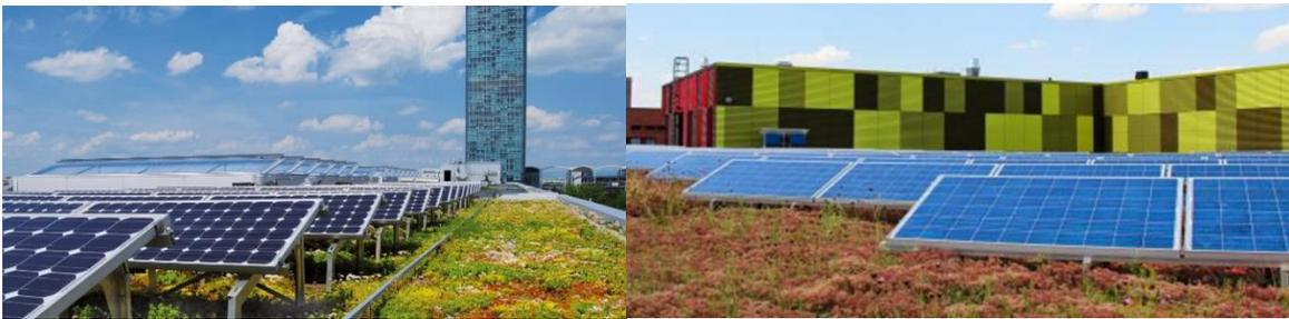
Abbildung 2-11: Gründächer in Kombination mit PV-Aufdachanlagen in München (Technologie Zentrum) und Leipzig (Bio Cube)<sup>28</sup>
