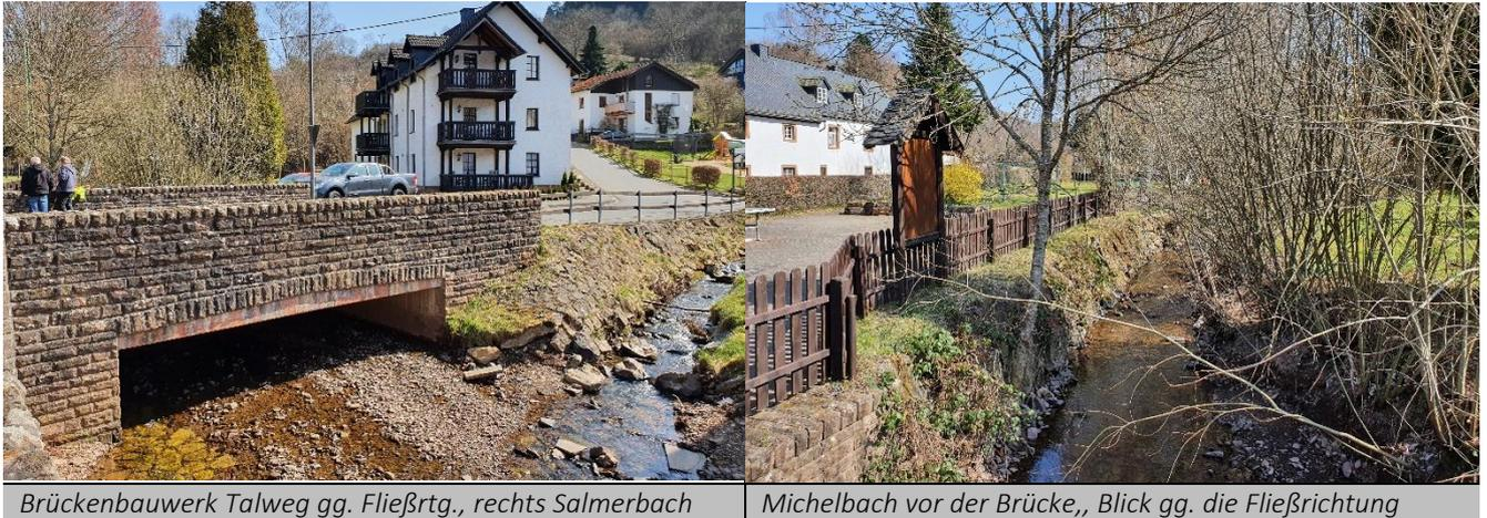
**Situation** An der Brücke des Talwegs staute Michelbach an beim Hochwasser 2021 zurück, auch durch die Mündung des Salmerbaches, unmittelbar unterhalb der Talweg-Brücke und vor der Brücke der Birresborner Straße, wurde der Rückstau verstärkt.
