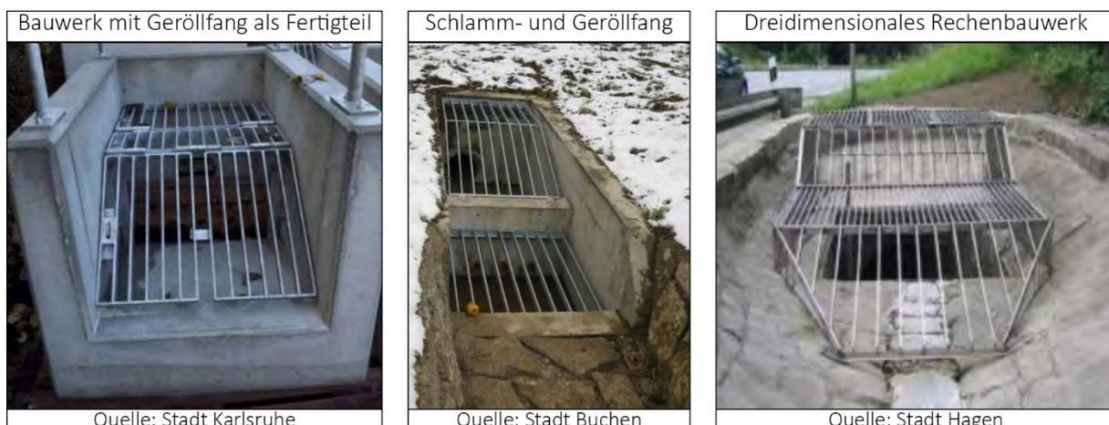
Bei Einlaufbauwerken handelt es sich um Bauwerke, die für den speziellen Einsatzfall geplant werden müssen. Hierbei sind neben den kleinräumigen Verhältnissen (Schachttiefe, Lage im Verkehrsraum/neben dem Verkehrsraum, Längsgefälle, Kanaldurchmesser, Längsgefälle des Kanals, unterhalb befindliche kritische Bebauung) auch einzugsgebietsbezogene Kennwerte zu berücksichtigen: Größe und Struktur des Einzugsgebietes, Landnutzung, Belastung mit Geröll und Treibgut etc.
