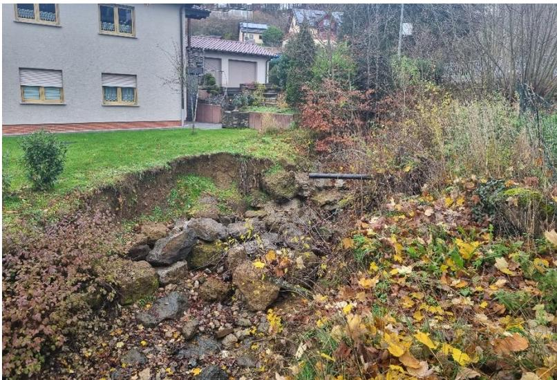
*Abbildung 6: Schaden im Gewässerbett und beschädigtes Gewässerufer*
