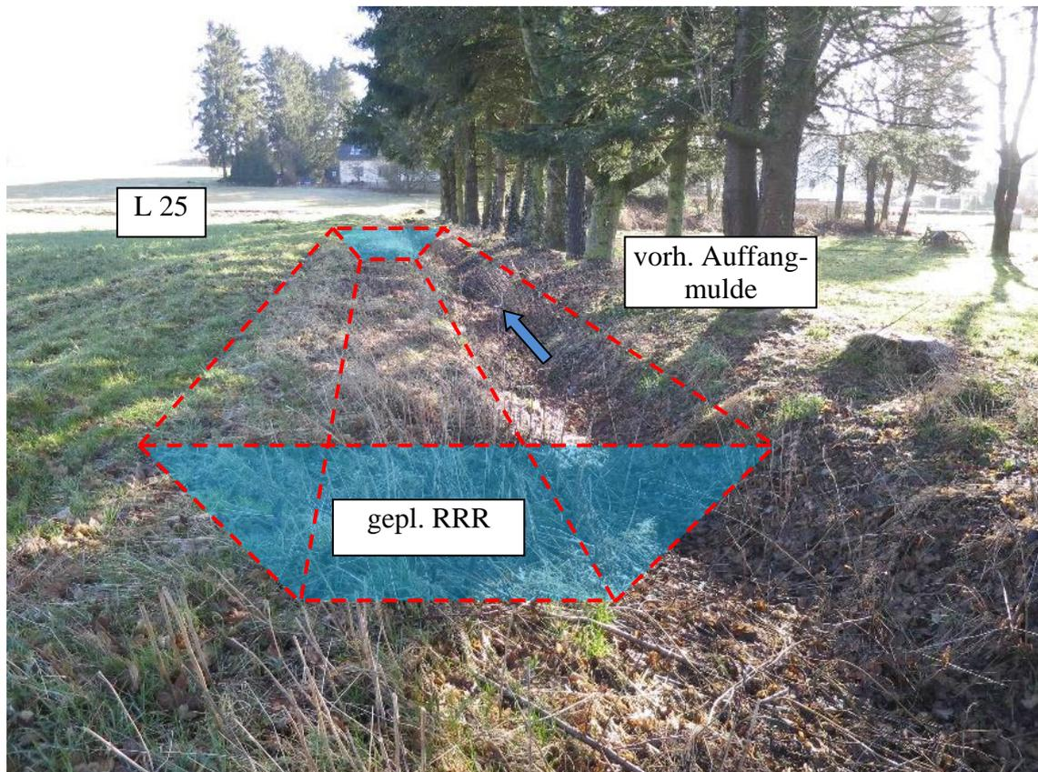
Durch die Errichtung eines Regenrückhaltebeckens (Skizze in Foto) wird das Starkregenereignis zunächst gebremst, aufgefangen und kontrolliert in den vorh. Graben weitergegeben. Die bereits vorh. Auffangmulde wird baulich deutlich vergrößert und als Regenrückhaltebecken ausgebaut.
