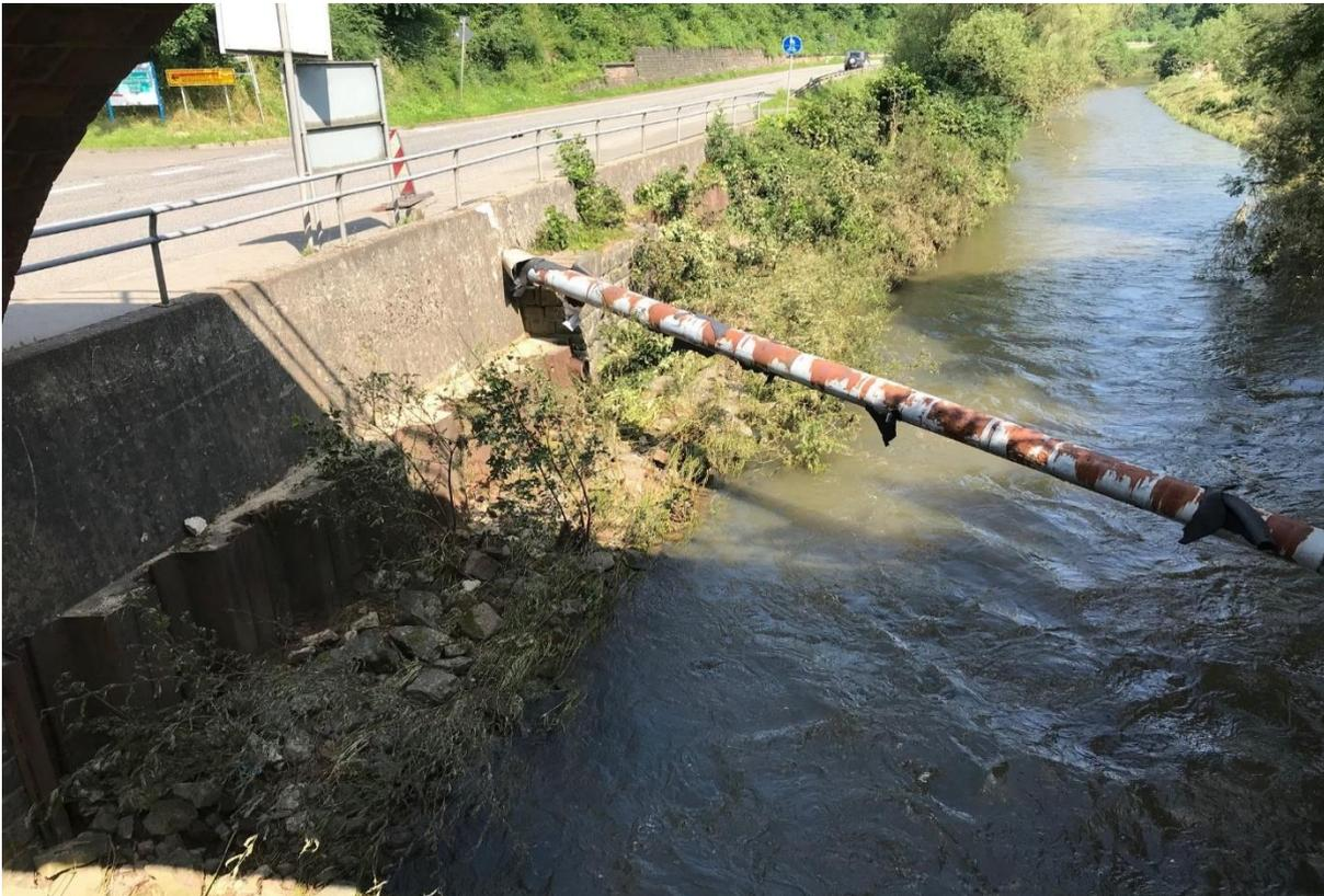
Die Kanalrohrbrücke DN 250 wurde seinerzeit oberirdisch als geschweißte Stahlrohrleitung mit einer wärme gedämmten Mantelauskleidung und einer Spannweite von rd. 18,50 m ausgeführt.
