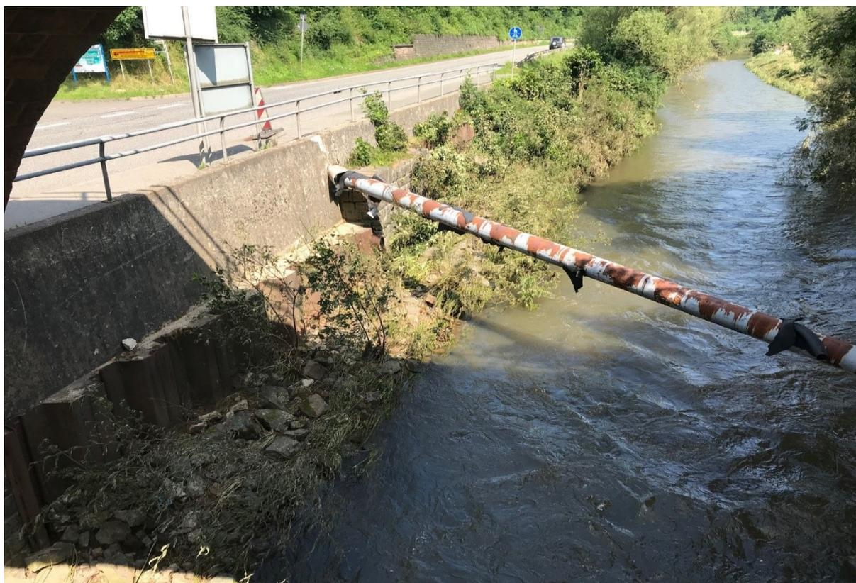
Die Kanalrohrbrücke DN 250 wurde seinerzeit oberirdisch als geschweißte Stahlrohrleitung mit einer wärmedämmten Mantelauskleidung und einer Spannweite von rd. 18,50 m ausgeführt.
