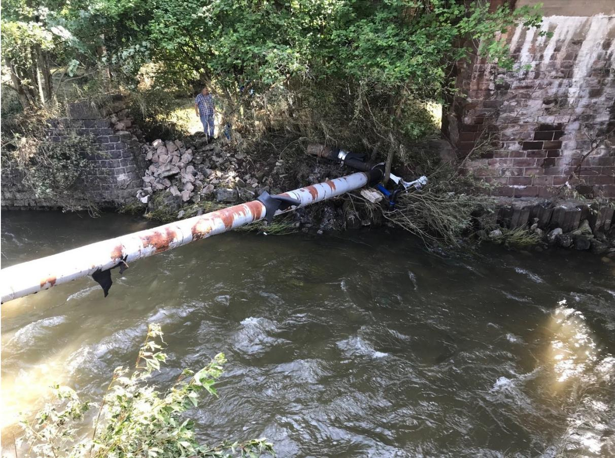
Durch das Hochwasser ist mit steigendem Flusspegel die Rohrleitungsbrücke in Fließrichtung mit der Kyll nach rechts unten weggeknickt. Auf Grund der Wassermassen, Treibgut, etc. wurde der Druck auf die rechtwinklig zum Fluss verlaufende Rohrleitung so groß, dass die Leitung am Ablauf aus dem gemauerten Widerlager herausgebrochen ist.
