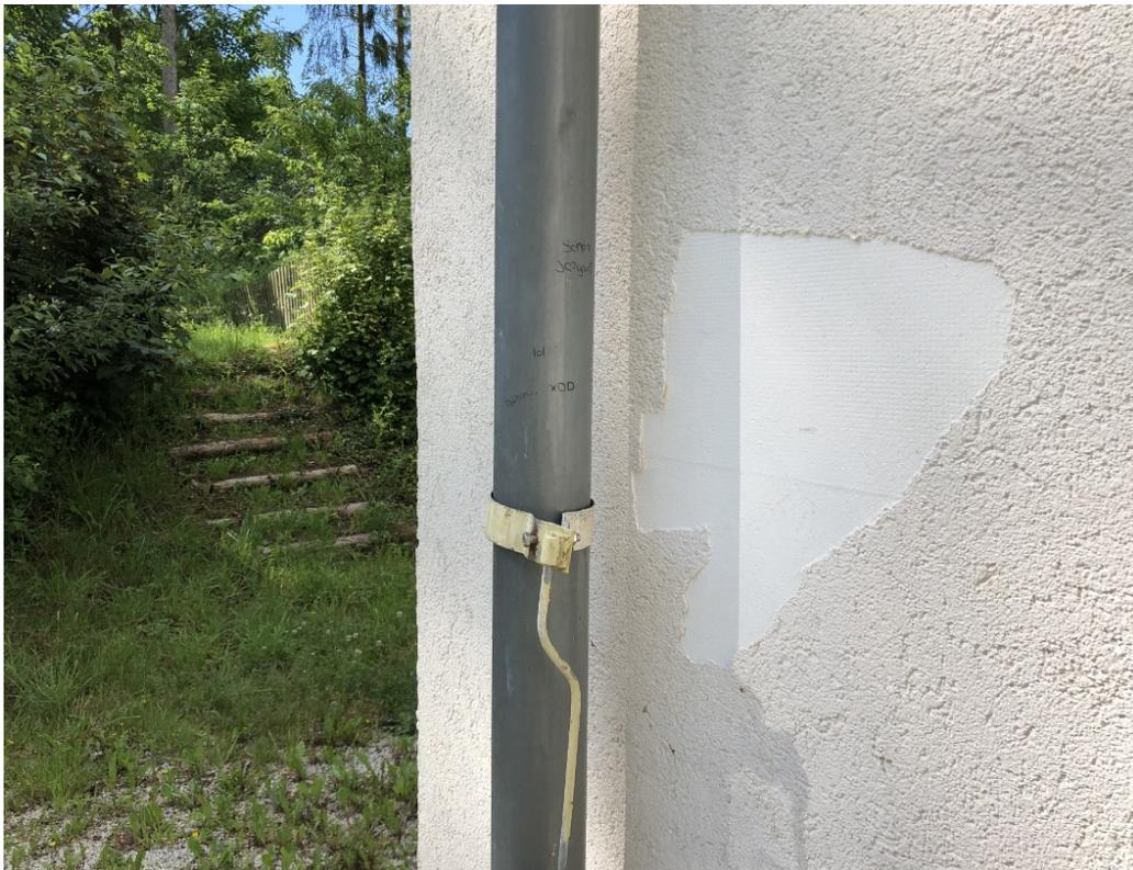
*Abbildung 1 Beispiel einer großflächigen Fehlstelle im Außenputz des DGH Büscheich*
